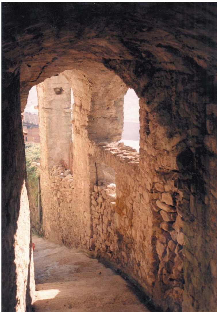
30. Malgrate: la strada coperta medievale
